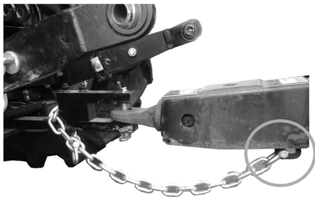
作業機へのチェーステー溶接例 (S-1800)
