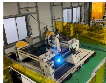
溶接ロボット
